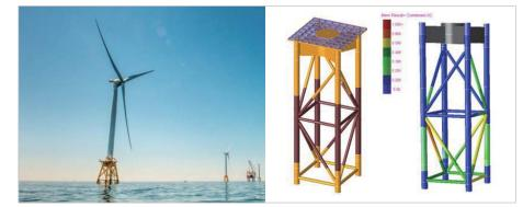
해상 공사비 절감을 위한 해상풍력 자켓 지지구조물 일체화 설계 및 시공기술 개발(KETEP) - 해상풍력 터빈용 자켓 하부구조의 통합 설계 및 설치비용 절감을 위한 시공방법
